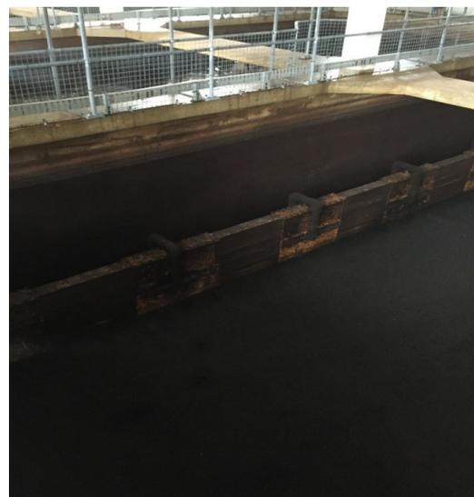
Abbildung 3: Foto eines entwässerten Filters mit Rinnenkanal an der Rückwand, Bündelungswand und Filterbett im Vordergrund
